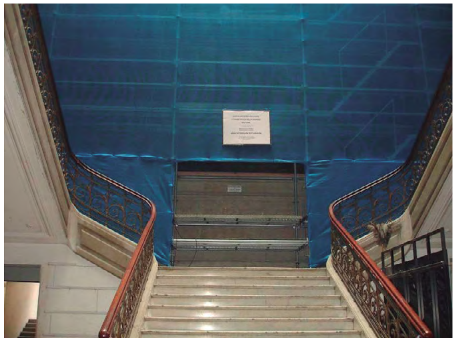
Figura N° 1a y 1b. Inicio de obra, armado del andamio en la escalera del hall central. Fuente: Todas las fotos son del autor.
