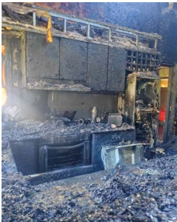
Figura N° 8. Obsérvese los residuos sobre la mesada, celulosa con decoloración parcial. Se registran restos sin combustionar dentro de una misma masa. Fuente: Gentileza Bomberos Voluntarios Villa La Angostura.
