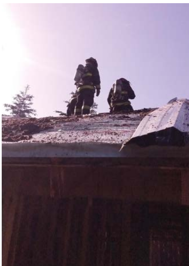
Figura N° 2. Principio de Incendio de vivienda en obra, avance en un 30%, entre techo de dos aguas aisladas con celulosa. Bomberos realizan ataque directo con remoción de chapas. Las tareas de extienden por más de 3 horas. Fuente: Gentileza Bomberos Voluntarios Villa La Angostura.
