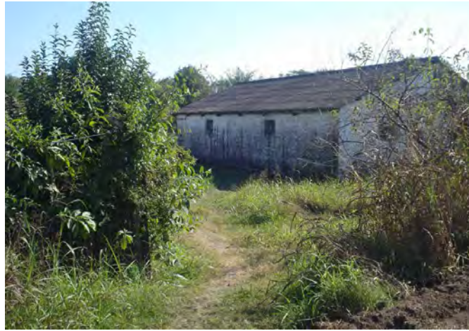
Figura 2: Acceso por camino de tierra al Galpón 9 por la parte posterior.
