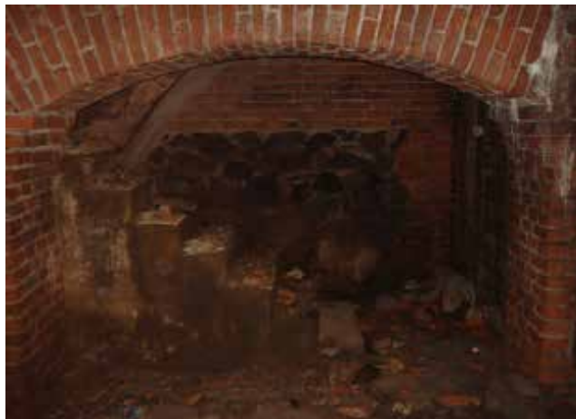
Figura 23: Debajo de la escalera, en el piso
