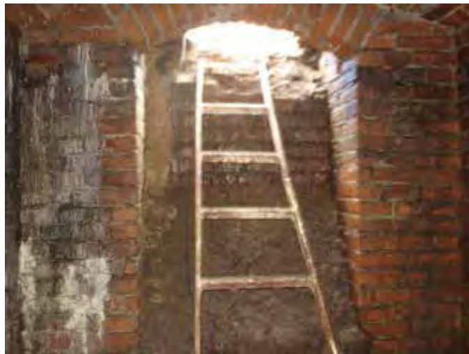
Figura 17: Vista de la entrada desde el interior.
